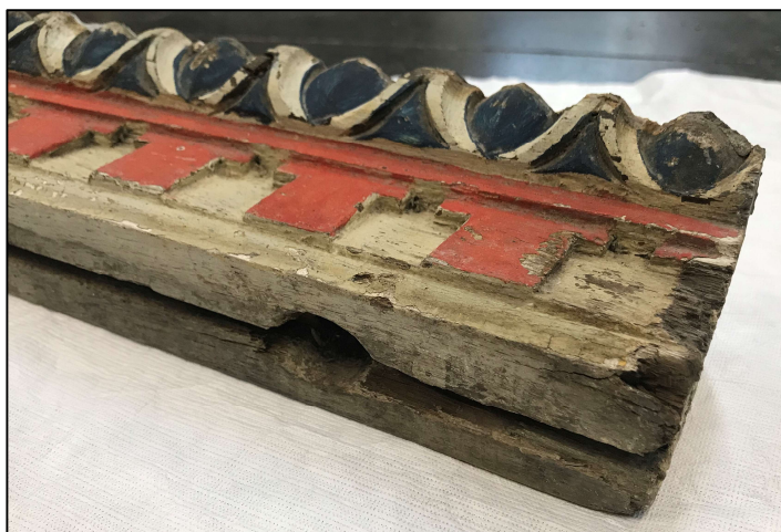
Ill. 23 : À gauche : Détail de l'assemblage en partie inférieure du retable. La moulure à godrons est masquée par une moulure de façade. Ci-dessus : détail de la rainure et du trou de cheville situé en partie inférieure de la moulure à godrons.
