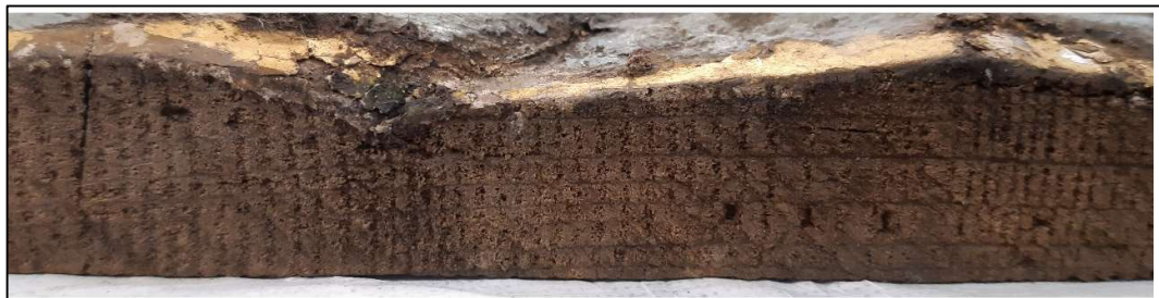
Ill. 19 : Détail des perforations triangulaires présentes sur la tranche inférieure des panneaux.
