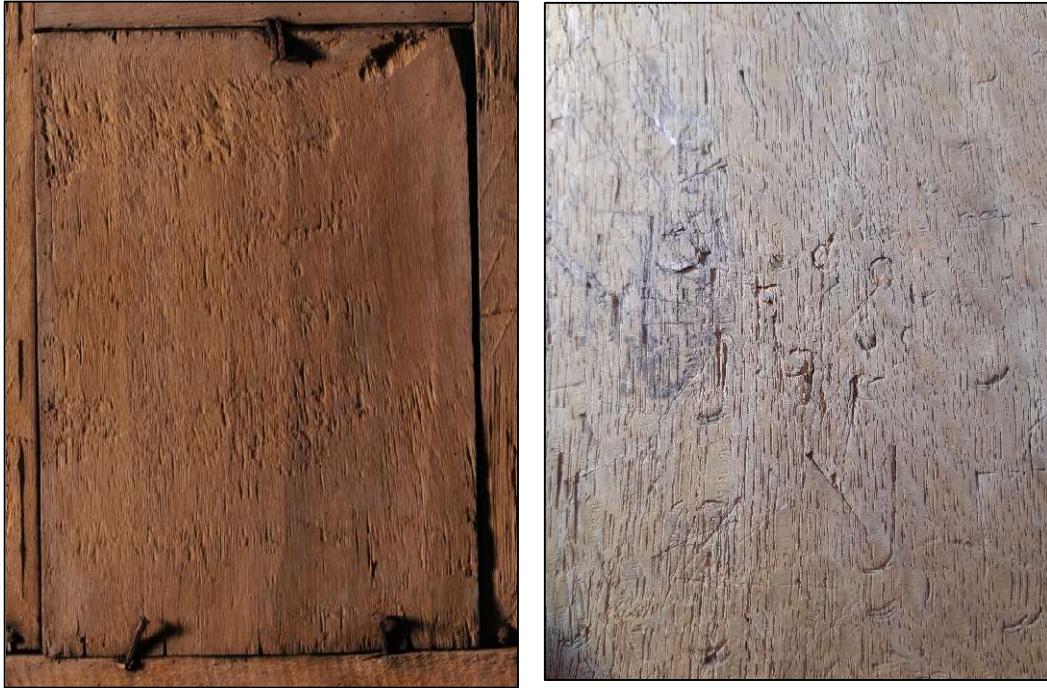
Ill. 20 : Exemple de traces de riflard, de gouges et de ciseaux étroits disséminées au revers des panneaux.
