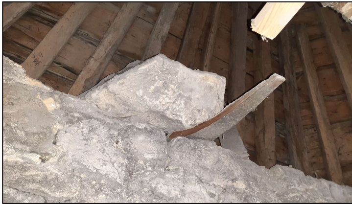
Ill. 35 : Détail du bloc de pierre et de la latte de bois qui assuraient le maintien du retable à la verticale
