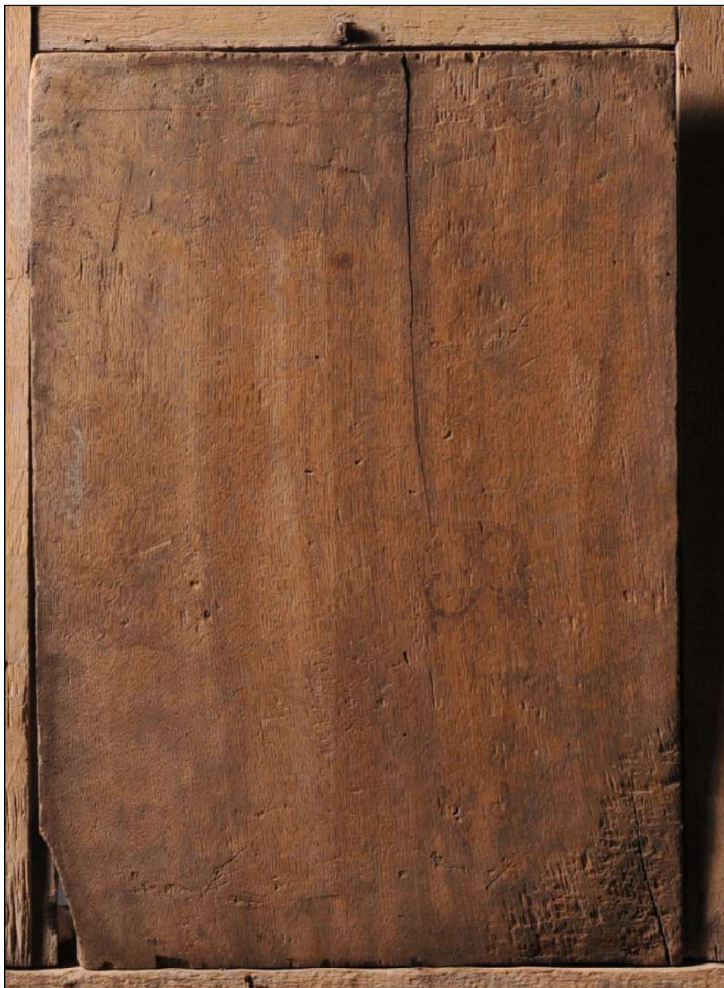
Ill. 45 : Vue générale du revers en lumière rasante, mettant en évidence les traces de riflard et les traces de ciseaux.
