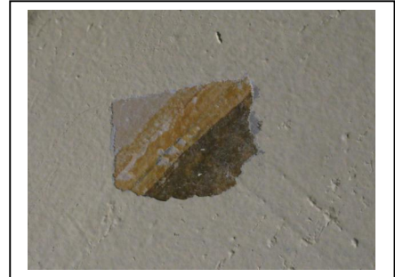
Détail de la limite de l'arcature d'une des deux portes à arc surbaissé. La cinquième strate imitant un appareillage en pierre et marbre présente un léger relief correspondant aux limites feintes de l'appareillage.
